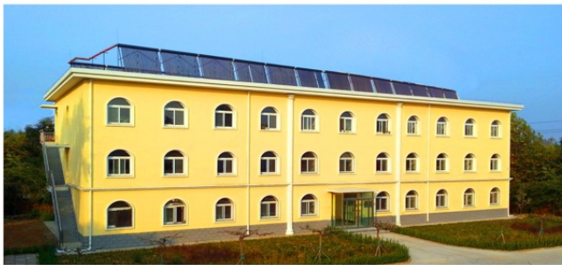
太阳能供暖采暖建筑实景
